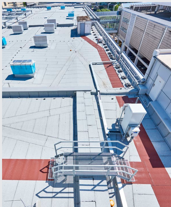
Sanierung der Messehalle 6 in Frankfurt a. M. mit 9.500 m 2 Dachfläche
