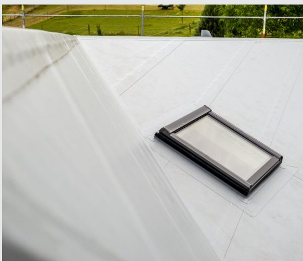
Eine komplexe Dachform mit vielen Details – für die Wolfen Kunststoffbahn kein Problem
