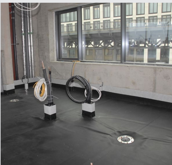
Abdichtung einer Großküche zum Bauwerksschutz
