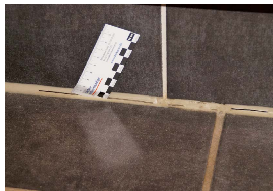
Undichte, abgerissene Silikonfugen sind oftmals die Ursache für einen Feuchteintrag in die Konstruktion.
