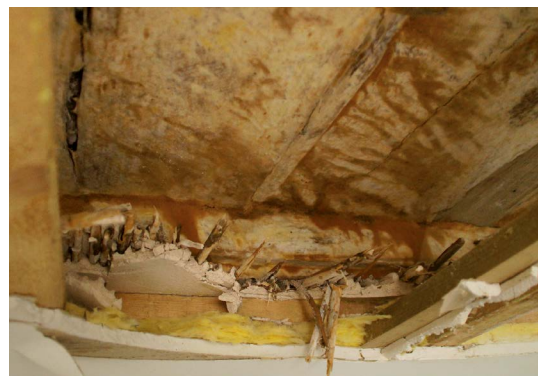
Die Holzbalkendecke ist durchfeuchtet und durch einen pflanzlichen Holzschädling befallen. Die Standsicherheit ist nicht mehr gegeben.
